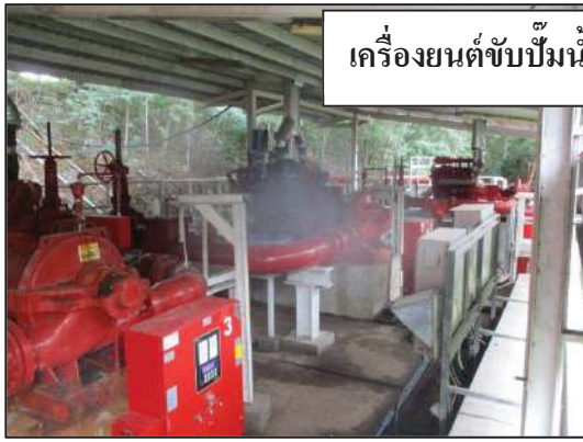
ระบบ Fixed Water Monitor
